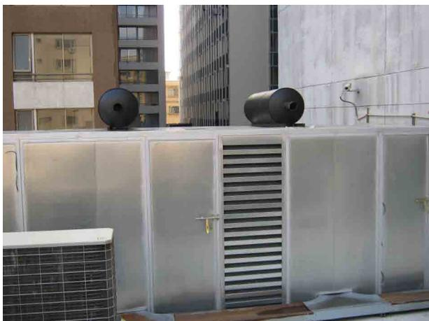
Encierro Acústico diseñado y fabricado por Sonoflex
