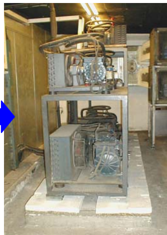
Centrales frigoríficas en salas de máquinas
