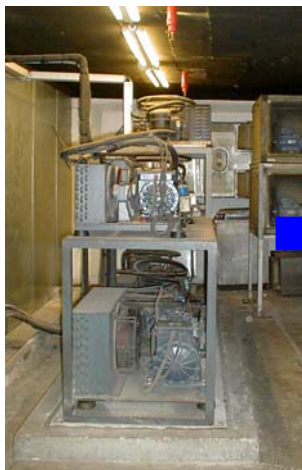
Centrales frigoríficas en salas de máquinas
