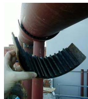
En puntales y cunas para apoyos en peines de tuberías
