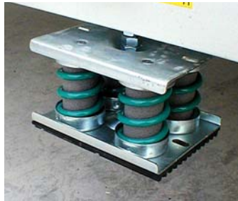
Como alfombrillas antivibratorias en las bases de los aisladores
