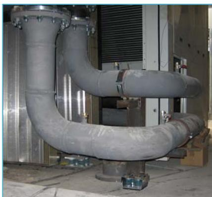
Aislamiento vibroacústico de apoyos para tubería de agua
