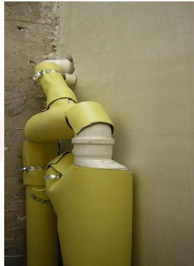
Acústicamente, el Fonodan BJ funciona disipando la energía, al modificar la rigidez del ducto, a través de la membrana de alta densidad y al quedar desacoplado de la estructura del edificio.
