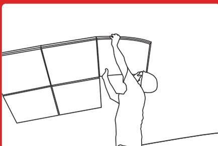
Comenzar la aplicación de acuerdo a la orientación elegida, presentando la placa en la posición correcta y sin estirarla para evitar deformaciones. En aplicaciones en pared colocar desde arriba hacia abajo.
