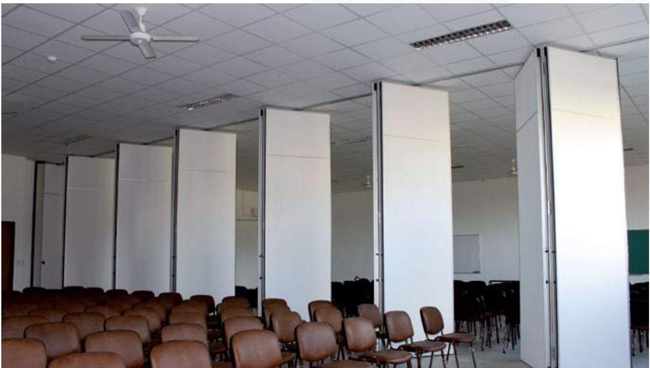
Sistema modular para dividir física y acústicamente grandes superficies, permitiendo el uso parcial de los recintos con total privacidad. Posee un sistema de riel suspendido y no requiere ningún tipo de guía en el piso. Permite almacenarlos a distancia de manera simple.
